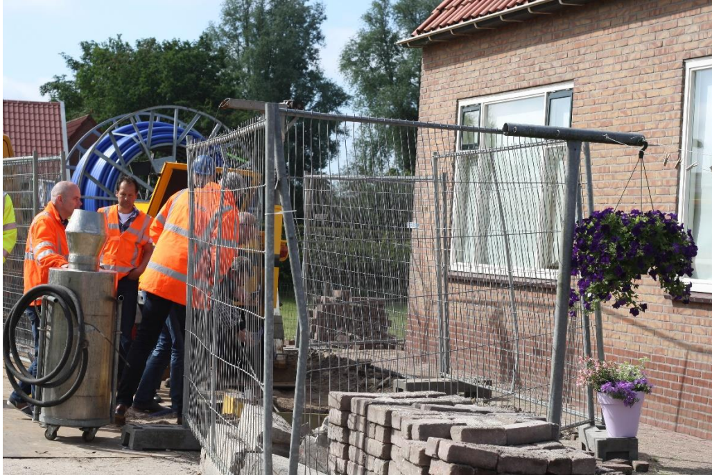
Figuur 3.2 Locatie werkgat vlak naast de woning.
