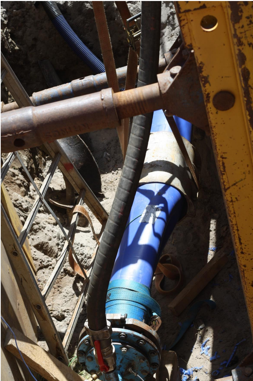
Figuur 3.4 Uitvouwen d.m.v. stoom, foto van uittredepunt.
